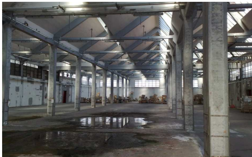
FABBRICATO D: VISIONE INTERNA DEL FABBRICATO
