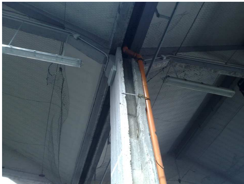
FABBRICATO C: VISIONE INTERNA DEL FABBRICATO (PILASTRO)
