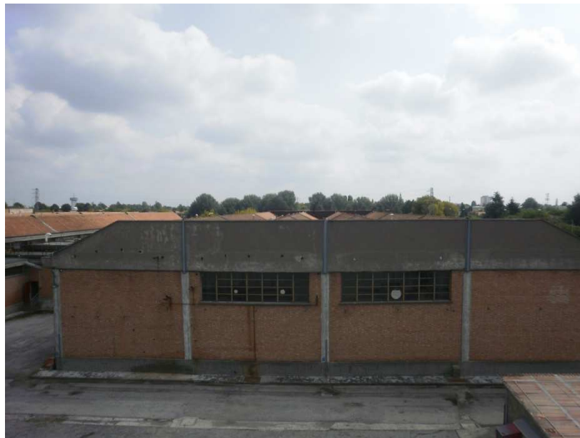
FABBRICATO C: VISIONE ESTERNA DEL FABBRICATO
