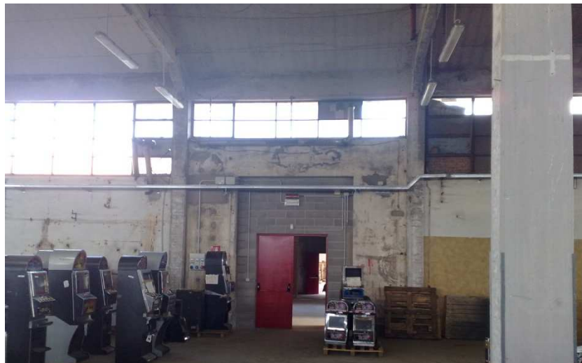
FABBRICATO C: VISIONE INTERNA DEL FABBRICATO
