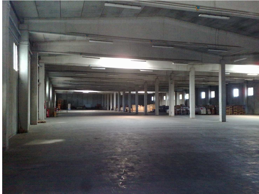
FABBRICATO B: VISIONE INTERNA DEL FABBRICATO
