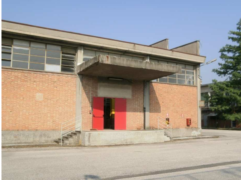
FABBRICATO E: VISIONE ESTERNA DEL FABBRICATO
