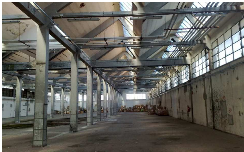
FABBRICATO D: VISIONE INTERNA DEL FABBRICATO
