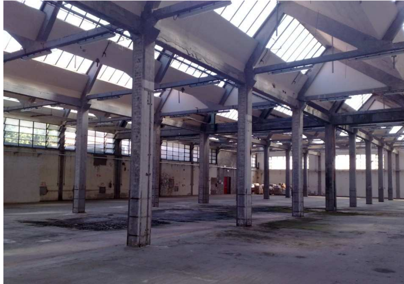
FABBRICATO D: VISIONE INTERNA DEL FABBRICATO
