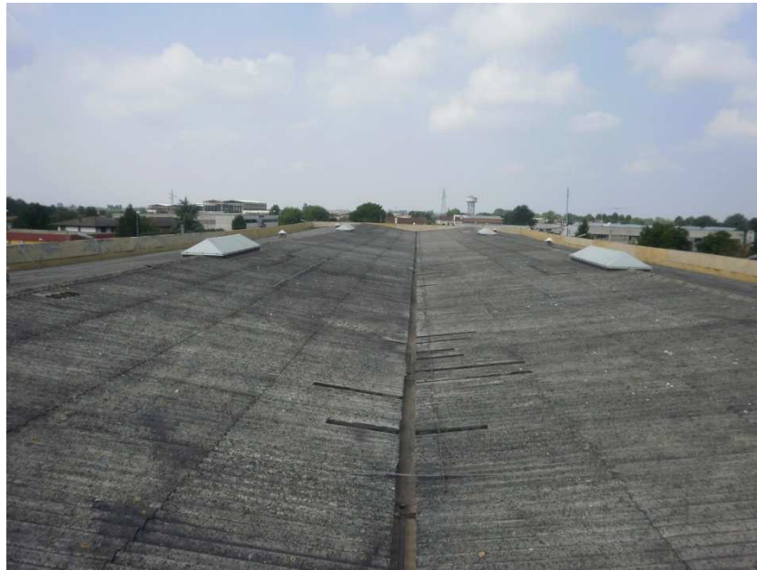
FABBRICATO B: VISIONE COPERTURA DEL FABBRICATO
