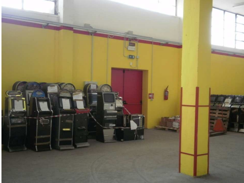
FABBRICATO E: VISIONE INTERNA DEL FABBRICATO (PILASTRO)
