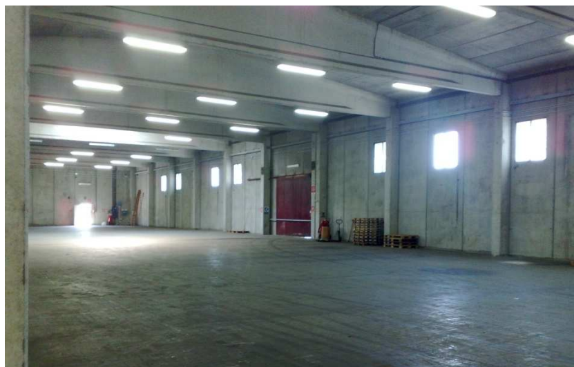
FABBRICATO B: VISIONE INTERNA DEL FABBRICATO
