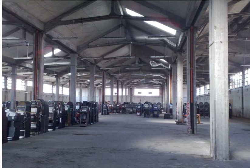
FABBRICATO C: VISIONE INTERNA DEL FABBRICATO
