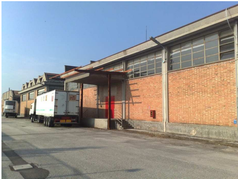
FABBRICATO E: VISIONE ESTERNA DEL FABBRICATO
