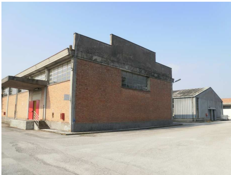
FABBRICATO E: VISIONE ESTERNA DEL FABBRICATO
