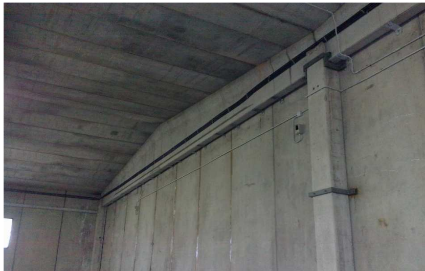
FABBRICATO B: VISIONE INTERNA DEL FABBRICATO
