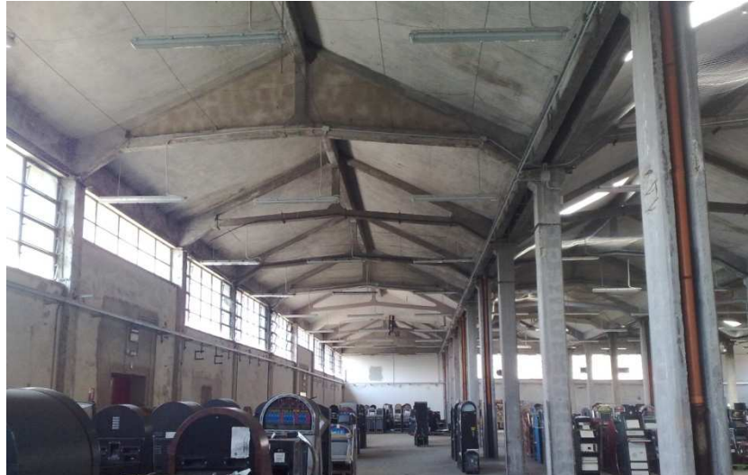
FABBRICATO C: VISIONE INTERNA DEL FABBRICATO
