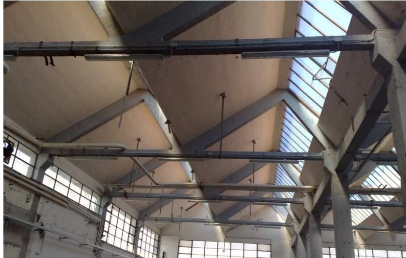
FABBRICATO D: VISIONE INTERNA DEL FABBRICATO
