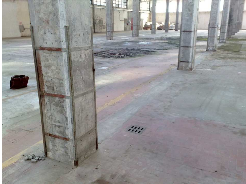
FABBRICATO D: VISIONE INTERNA DEL FABBRICATO (PILASTRO)
