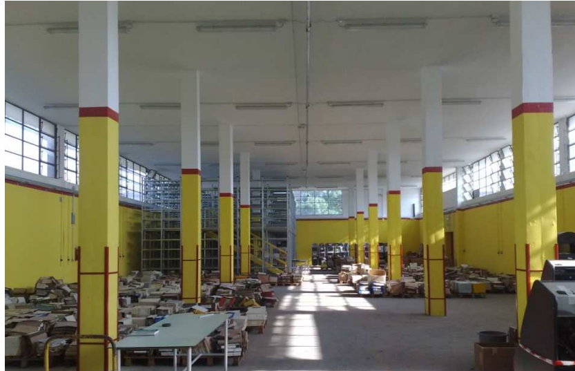
FABBRICATO E: VISIONE INTERNA DEL FABBRICATO
