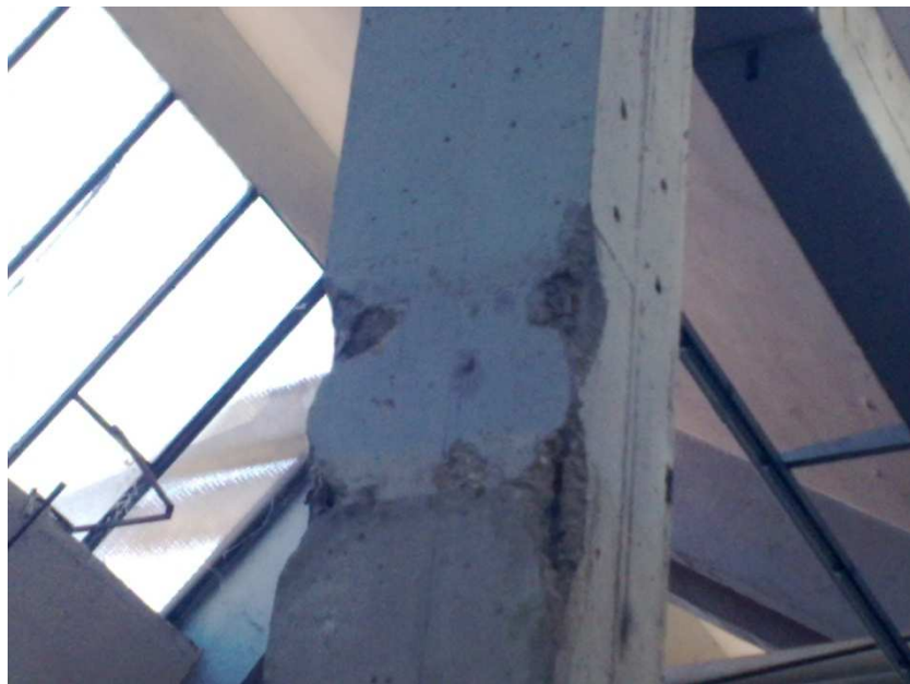
FABBRICATO D: VISIONE INTERNA DEL FABBRICATO (PILASTRO)
