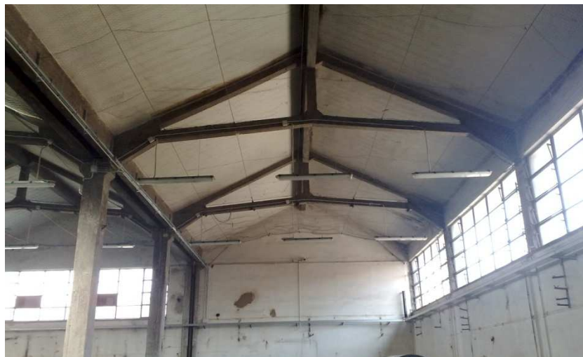
FABBRICATO C: VISIONE INTERNA DEL FABBRICATO
