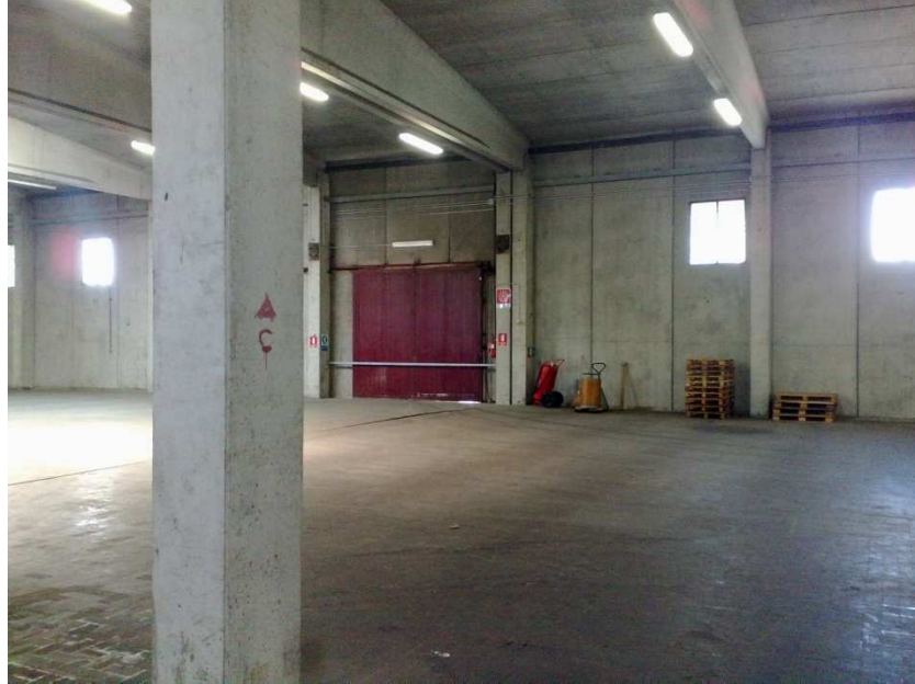
FABBRICATO B: VISIONE INTERNA DEL FABBRICATO (PILASTRI)
