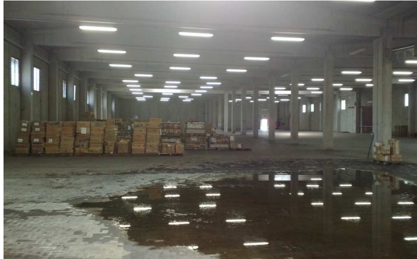
FABBRICATO B: VISIONE INTERNA DEL FABBRICATO
