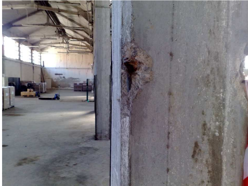
FABBRICATO C: VISIONE INTERNA DEL FABBRICATO (PILASTRO)
