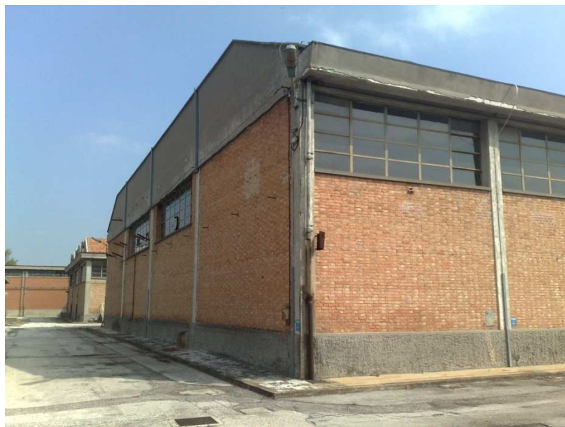
FABBRICATO C: VISIONE ESTERNA DEL FABBRICATO
