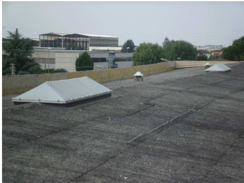
FABBRICATO B: VISIONE COPERTURA DEL FABBRICATO
