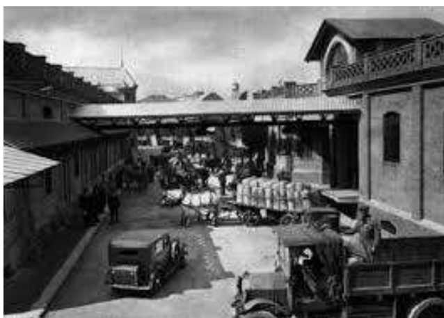
Fig. 3 – Magazzini Generali interno.
